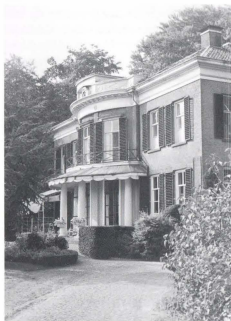
De voorgevel met nog de oorspronkelijke gevelbekroning.
